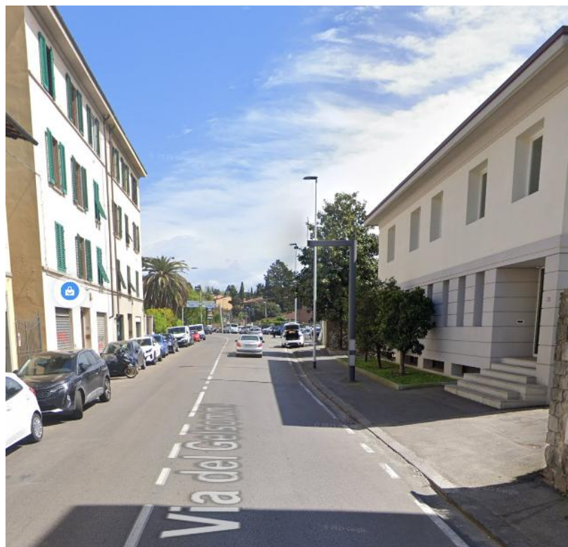
Figure 1: Firenze–Via del Ponte alle Mosse project section
